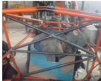
Figura 5-4: Construcción de Refuerzos Superiores
