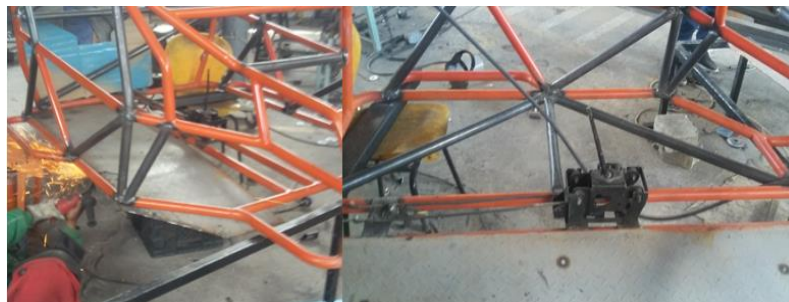
Figura 9-4: Construcción de Refuerzos del Piso
