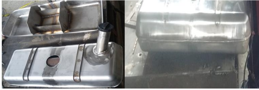
Figura 37-4: Soldadura de los moldes que darán forma al depósito de combustible
