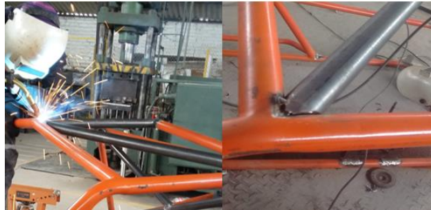
Figura 10-4: Colocación de Puntos de Soldadura
