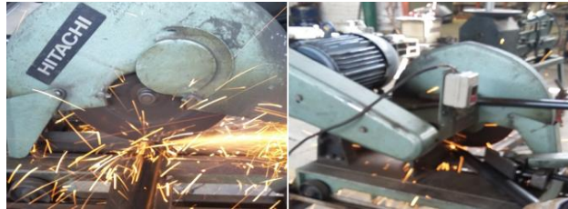
Figura 2-4: Corte del Material para los Refuerzos
