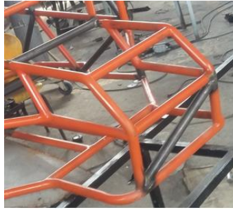
Figura 7-4: Construcción de Refuerzos Frontales
