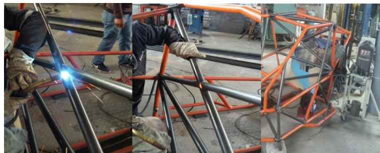
Figura 12-4: Soldadura de los Refuerzos
