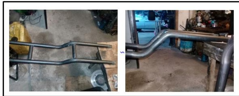
Figura 5-4: Acoplamiento de la estructura
