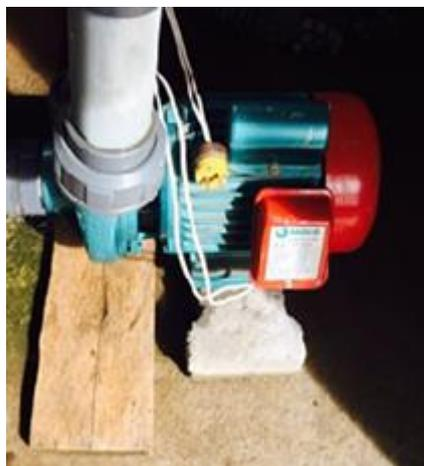
**Figura 16-2:** Bomba Eléctrica 2HP
