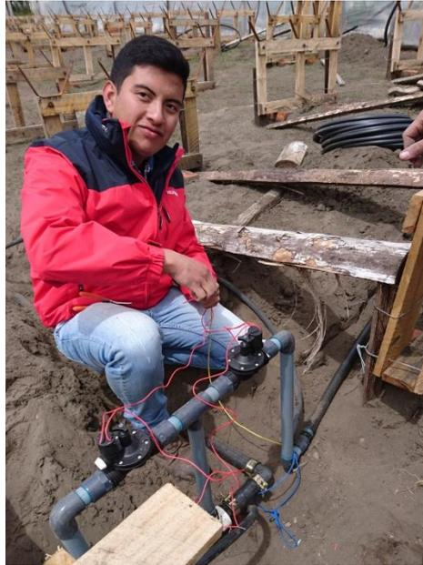
**Figura 2-3:** Instalación válvulas solenoides.
