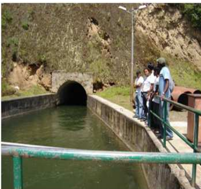
Figura 7. Tanque de Presión
