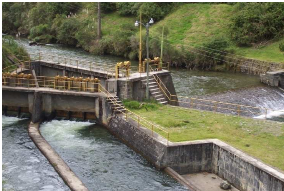
Figura 4. Captación de Caudal (bocatoma)
