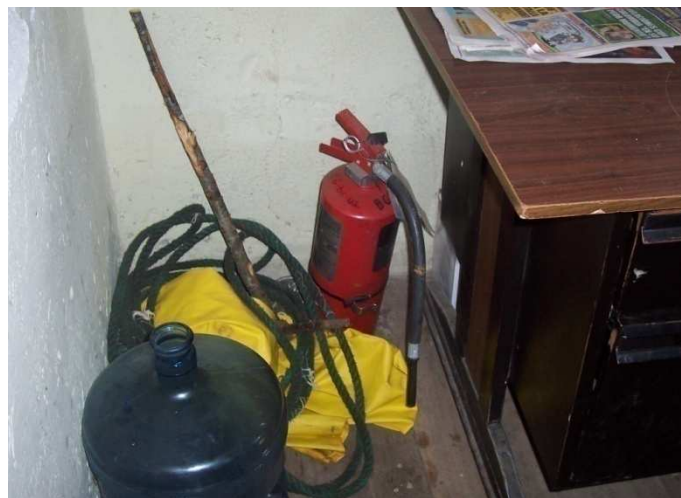
Figura 14. Ubicación de Extintor
