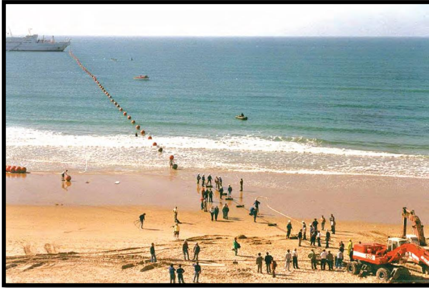
Figura 3-2: Instalación de cable submarino de fibra óptica
