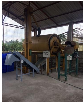
Figura 22-4. Ubicación final de la banda transportadora
