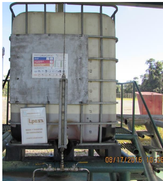
Figura 10-4: Acumulador de químico Bulk Tank Realizado por: Mancero, Ernesto, 2017
