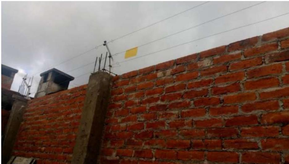
**Figura 47-2:** Cerca eléctrica en el perímetro de la vivienda
