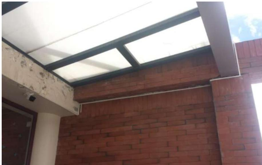
**Figura 3-41:** Instalación de las canaletas exterior del edificio
