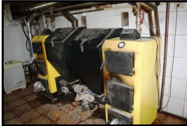
**Figura 22-1** Aplicación de quemadores de biomasa en piscinas
