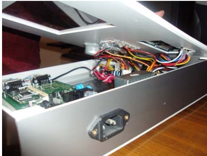
Figura.III.41. Interconexión de los elementos internos del Laboratorio TINI. Fuente: Los Autores
