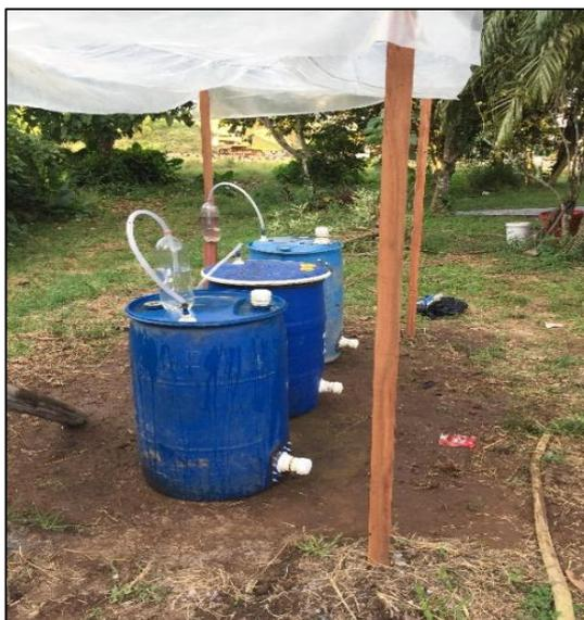
**Fotografía 6-3.** Construcción finalizada de los biodigestores y su respectiva cubierta.
