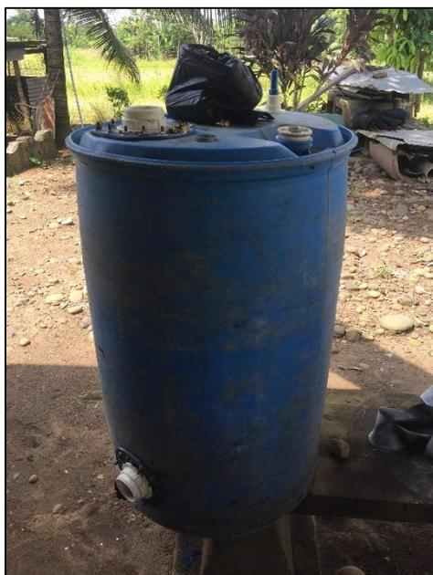
**Fotografía 1-3.** Instalación de la entrada de carga y salida de biol en el biodigestor
