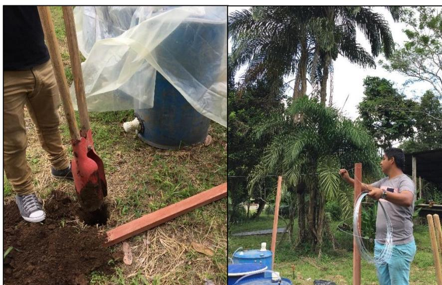
**Fotografía 5-3.** Colocación de las vigas de madera y alambre para la implementación de la cubierta para los biodigestores
