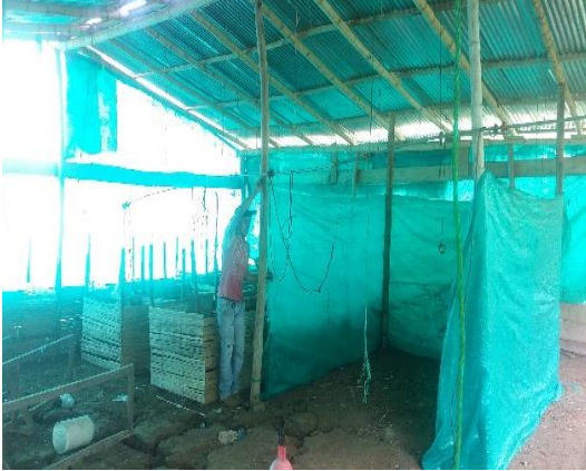
Foto 1. Construcción de instalaciones
