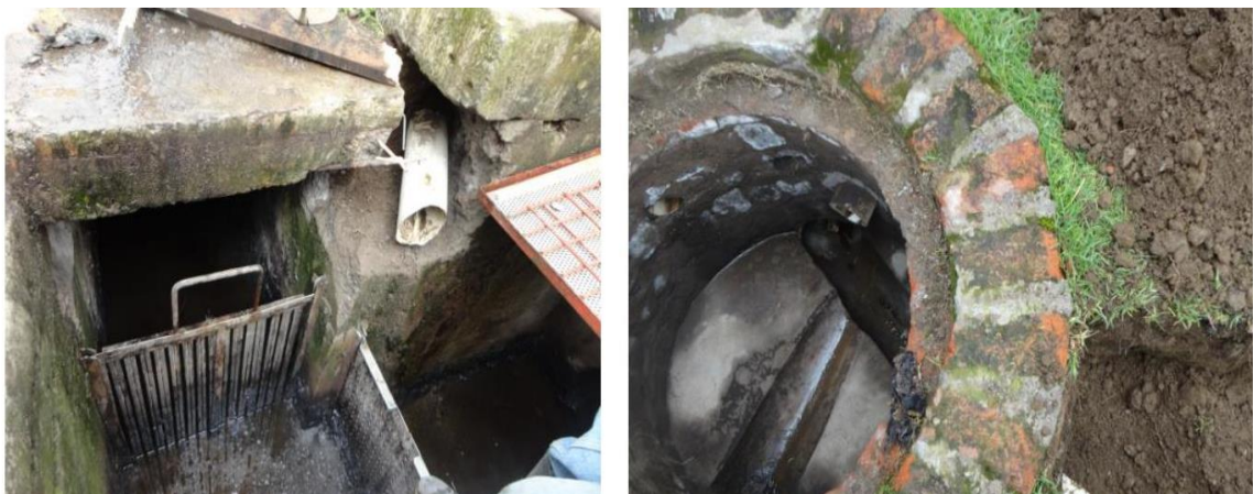
Fotografía 1-3: Conexión de la tubería de agua lluvia a la matriz de agua lluvia.
