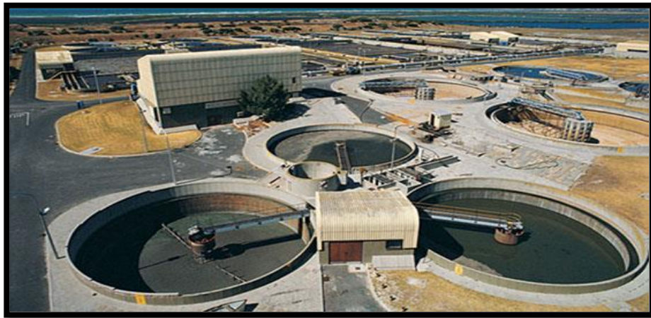
Figura 8.3 Planta de tratamiento con lodos activado
