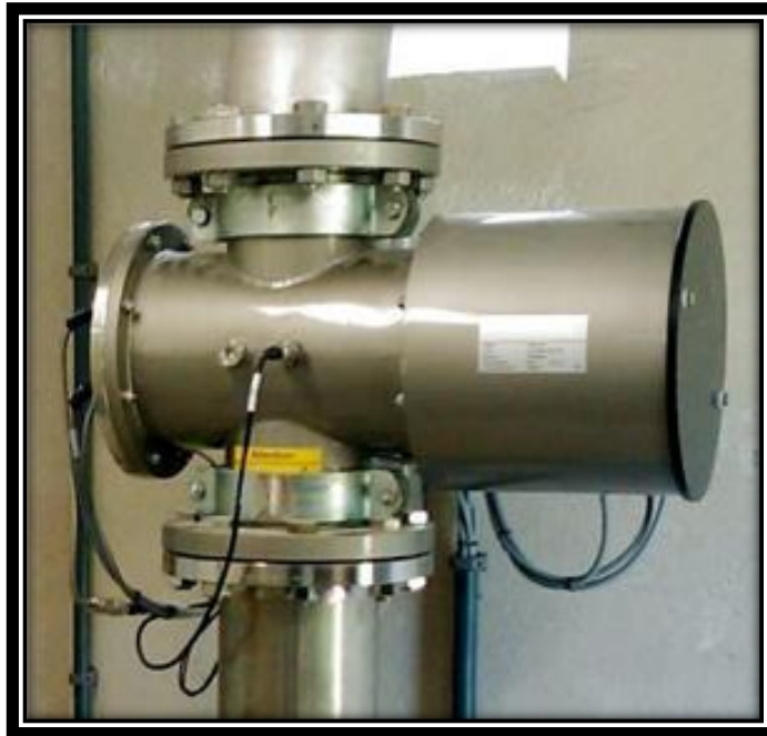
Figura 12.3 Desinfección ultravioleta UV
