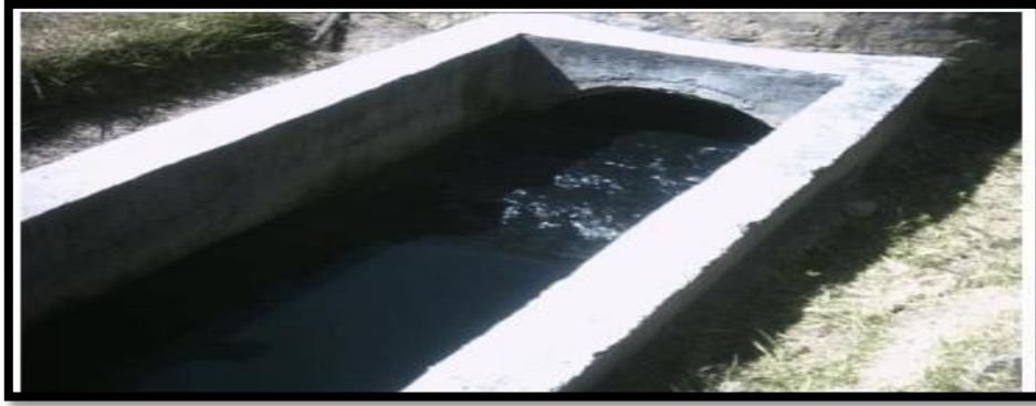
Figura 24.3 Canal de entrada a una planta depuradora
