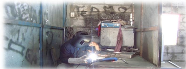
Trabajador realizando el proceso de suelda de las piezas del producto
