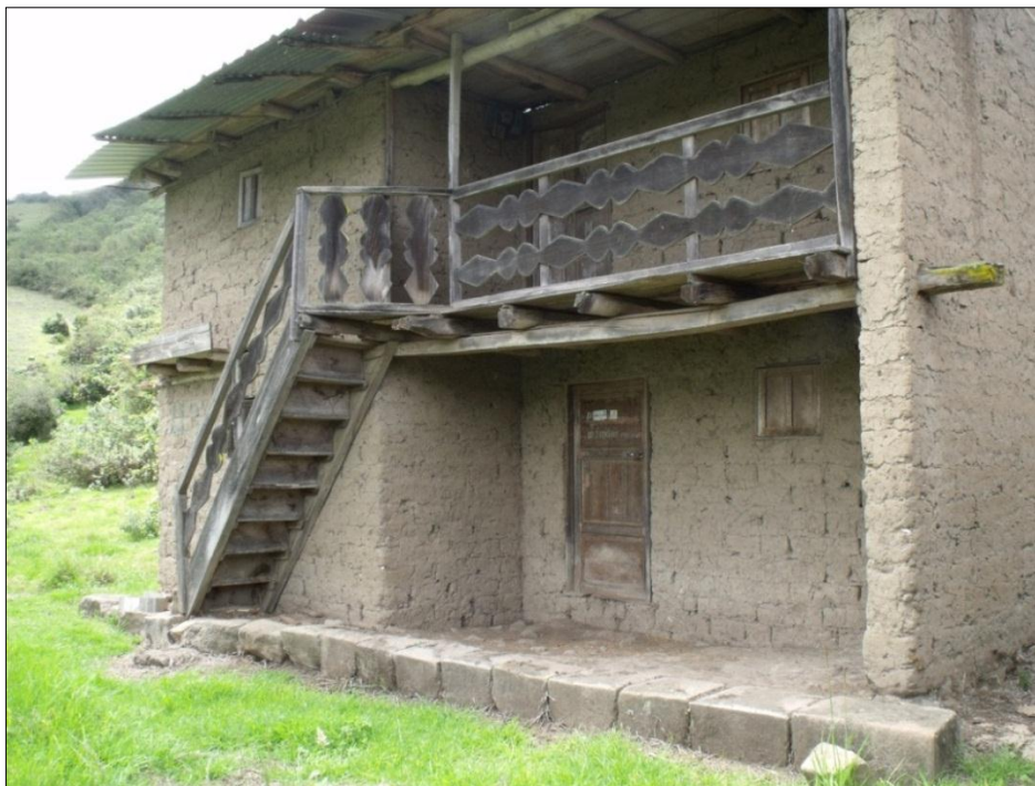
Casa de adobe y madera, con techo de hojas de zinc construida en el año 1985, pertenece al Sr. Manuel García y su familia. Tuvo que cambiar el techo hace 25 años, desde entonces ocupa las hojas de zinc en remplazo de la paja.
