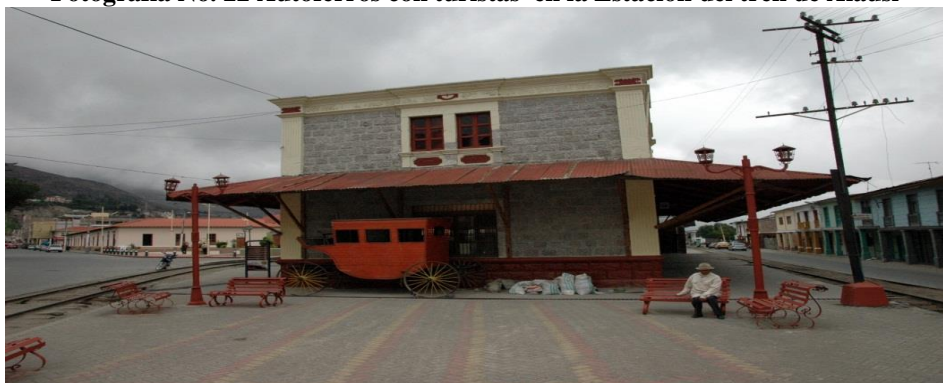
Fotografía No. 23 Estación del tren de Alausí remodelada
