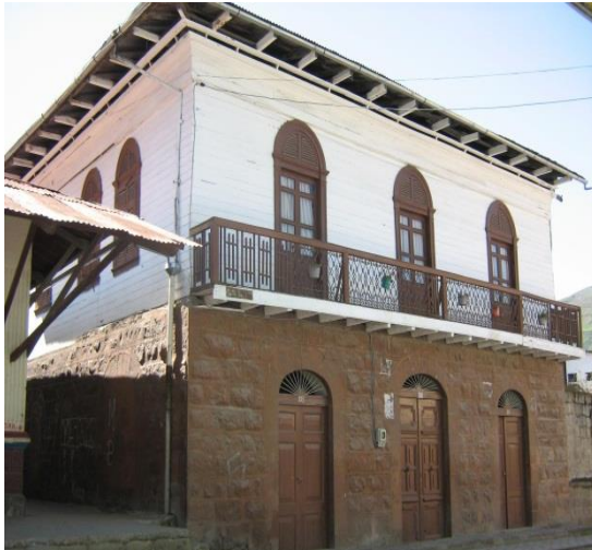
Fotografía No. 14 Vivienda ubicada junto a la Estación del Tren (calle Eloy Alfaro)
