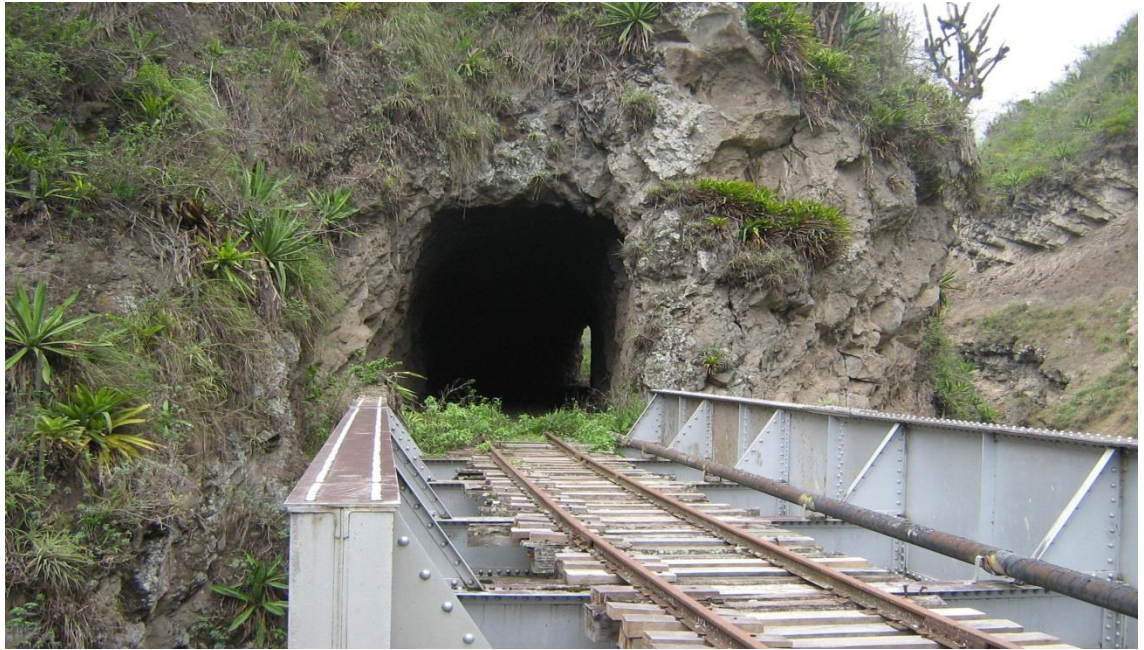
Fotografía No. 41 Túnel contiguo a la cascada de Pailaguayco
