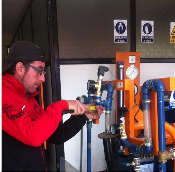
Figura 6-4. Válvulas de toma de muestra
