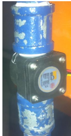
Figura 11-4. Instalación del sensor de flujo
