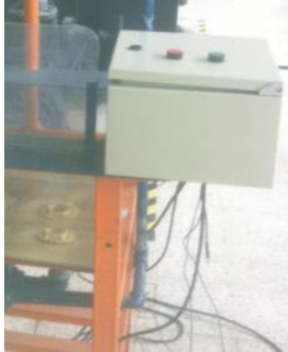
Figura 12-4. Instalación de la caja de mando
