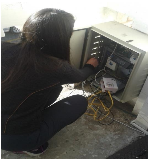
Figura 6-3: Instalación del mecanismo de control del Ambiente A
