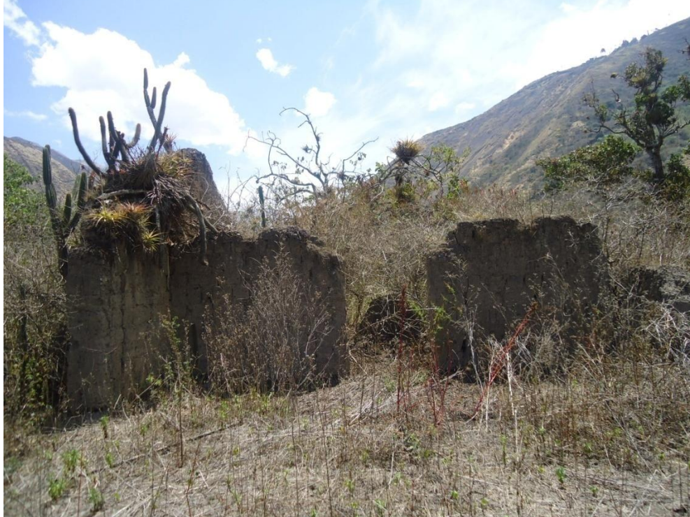
Fotografía N° 11 Casa en Ruinas Por: Glenda García
