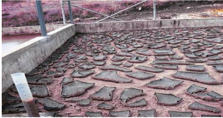
Figura 16-1 Lecho de secado de lodos
