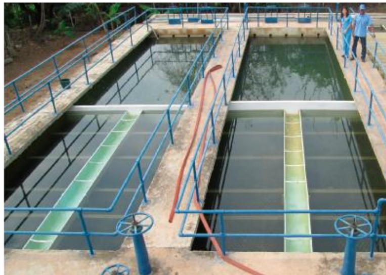
Figura 14-1 Sedimentador horizontal
