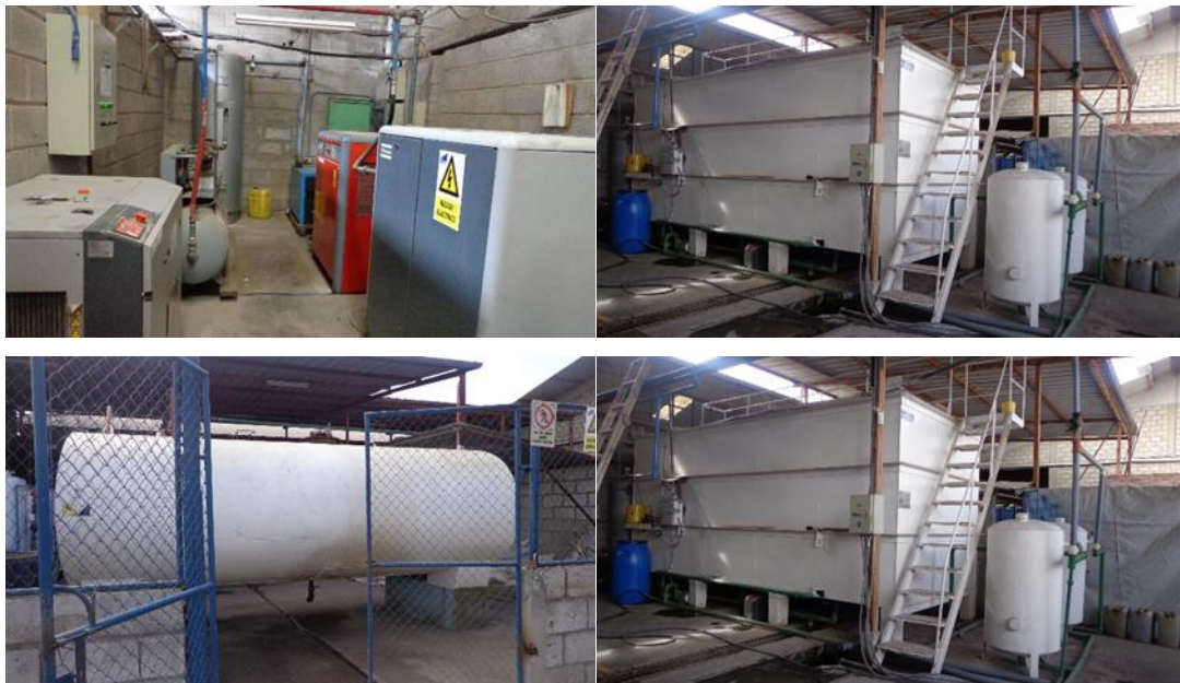
Figura 4-1 Área de servicios Fuente: ANDELAS CIA. LTDA. Realizado por: Juan Pablo Olovacha 2017
