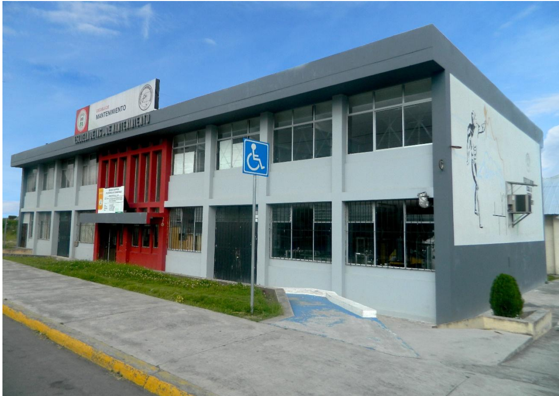
Figura 3-1. Fotografía Escuela de Ingeniería en Mantenimiento, ESPOCH
