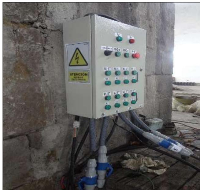
**Figura 7-2:** Conexión tablero principal con los elevadores
