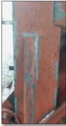
**Figura 37-3:** Cepillado y limpieza de la superficie
