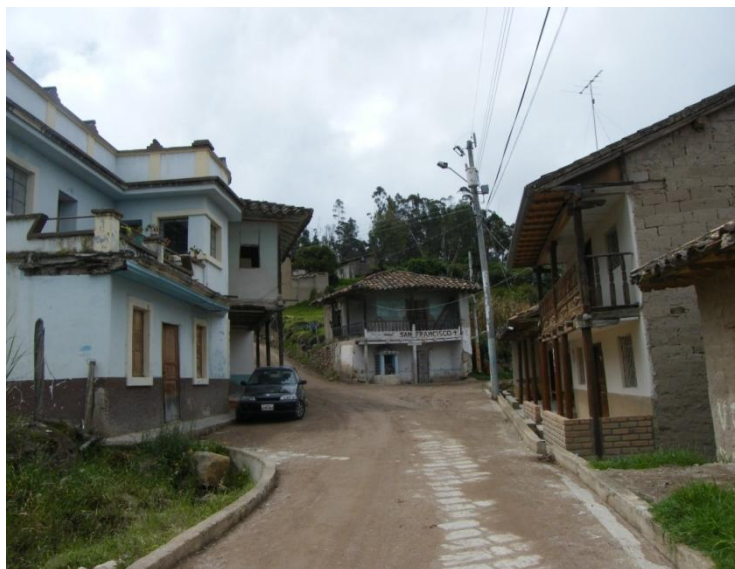
Fotografía N° 26 Arquitectura del cantón Oña
