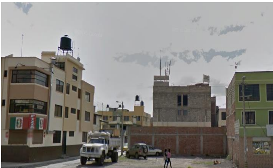
Figura 9-3: fotografía Antena 9, ubicada en las calles "Panamericana Rafael Jimena entre Francisco de Marcos y Avenida 11 de Noviembre" Realizado por: Flores, A; Carrasco, D. 2017
