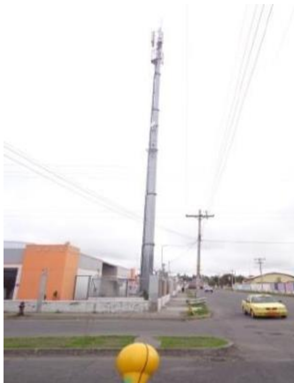
Figura 13-3: Fotografía Antena 13, ubicada en las calles "Avenida Celso Rodriguez y Bolívar Bonilla"
