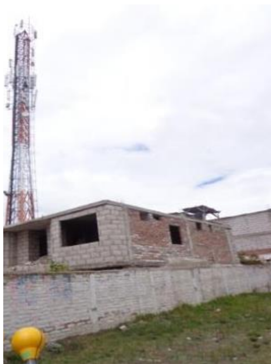
Figura 6-3: Fotografía Antena 6, ubicada en las calles ” Panamericana Sur y Avenida 11 de Noviembre”
