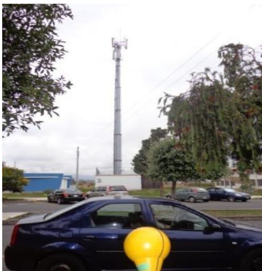
Figura 11-3: Fotografía Antena 11, ubicada en las calles ” Interior de la ESPOCH edificio de Química y de Física”
