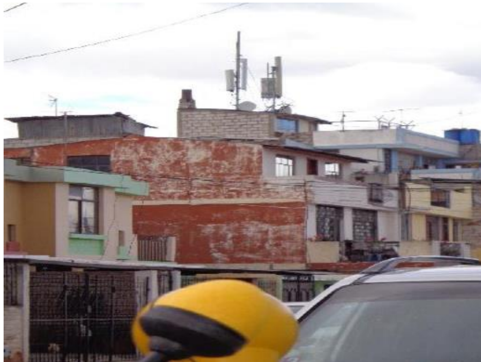
Figura 15-3: Fotografía Antena 15, ubicada en las calles” Juan de Lavalle y 14 de Agosto” Realizado por: Flores, A; Carrasco, D. 2017
