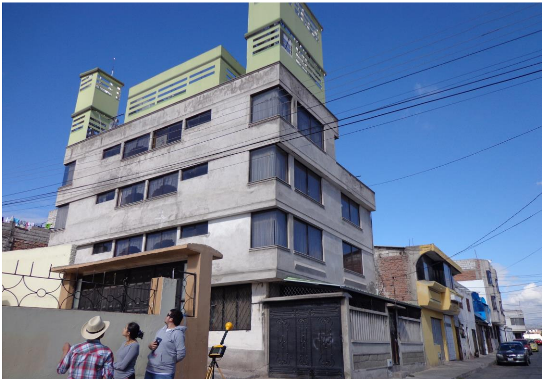
Figura 1-3: Fotografía Antena 1, ubicada en las calles ” 2 de agosto y 5 de junio” Realizado por: Flores, A; Carrasco, D. 2017
