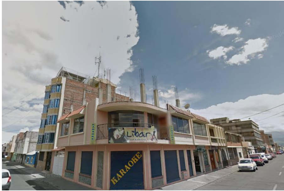
Figura 10-3: Fotografía Antena 10, ubicada en las calles” Venezuela y Juan Montalvo” Realizado por: Flores, A; Carrasco, D. 2017
