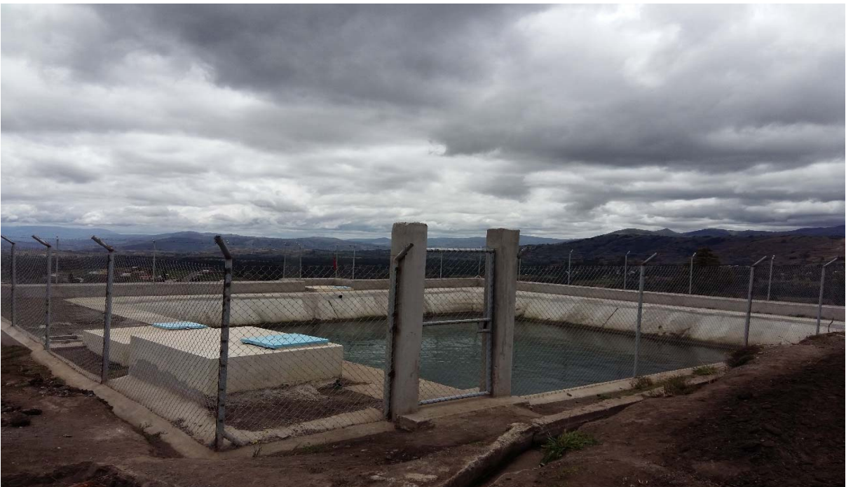
Fotografía 14: Reservorio de agua comunidad la Silvería Realizado por: Javier Cruz A; 2017
