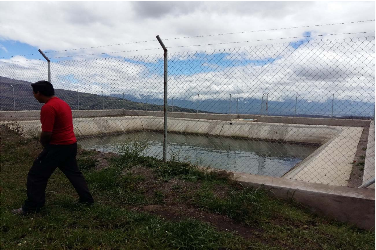
Fotografía 13: Reservorio de agua comunidad la Silvería Realizado por: Javier Cruz A; 2017
