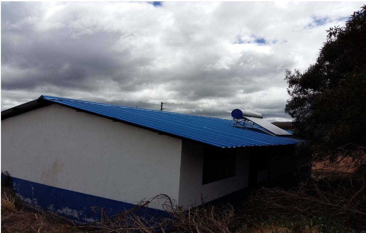
Fotografía 10: Panel solar comunidad Santa Rosa de Chuquipogúio Realizado por: Javier Cruz A; 2017
