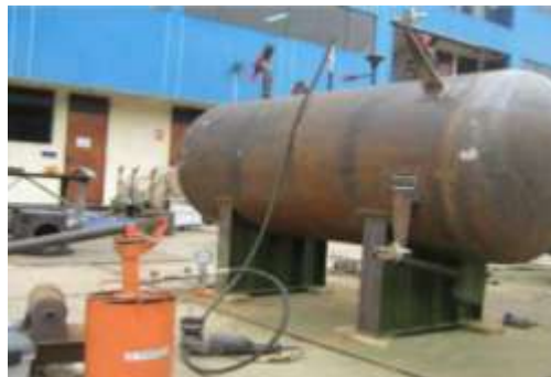
Figura 2-18. Ensayo hidrostático
