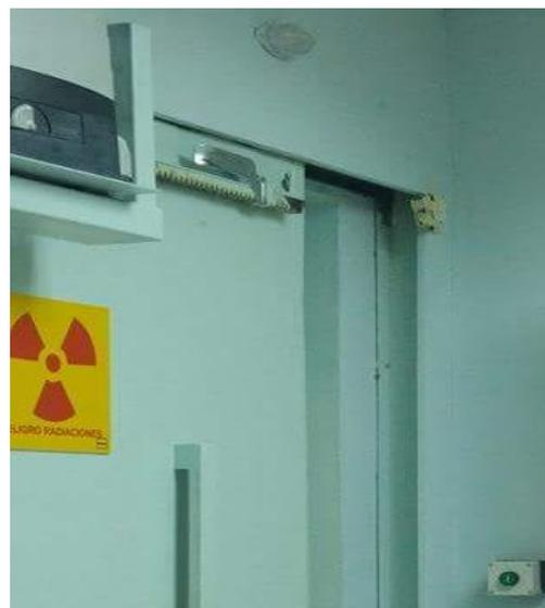
**Figura 8-3.**Interrupción de radiación al abrir la puerta B
