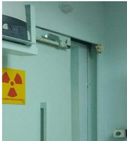
**Figura 58-3.**Interrupción de radiación al abrir la puerta B.
