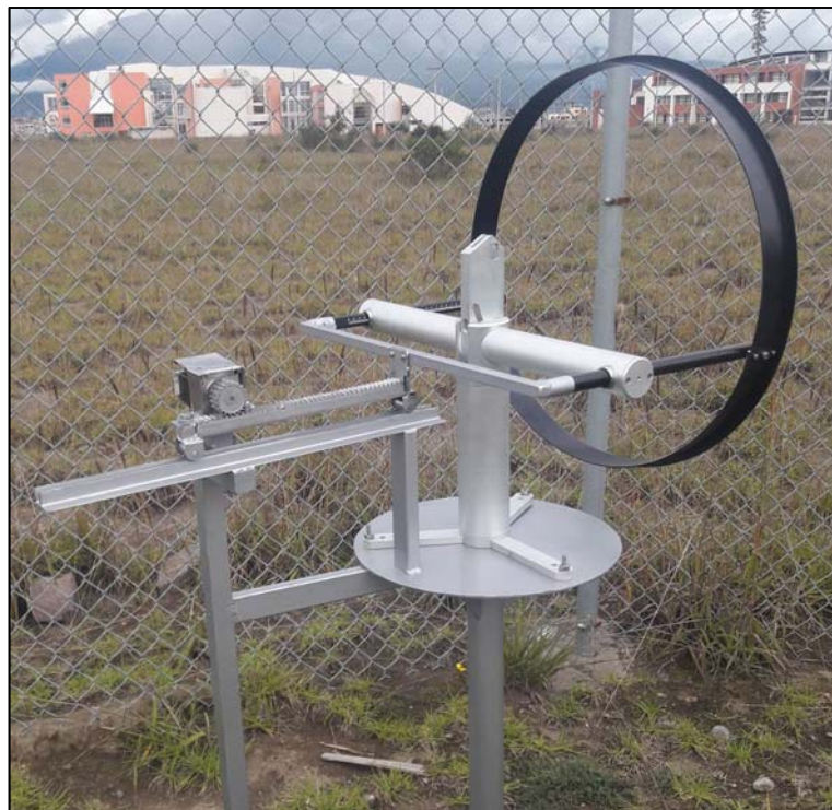
Figura 6-2. Sistema mecánico piñón-cremallera instalado
