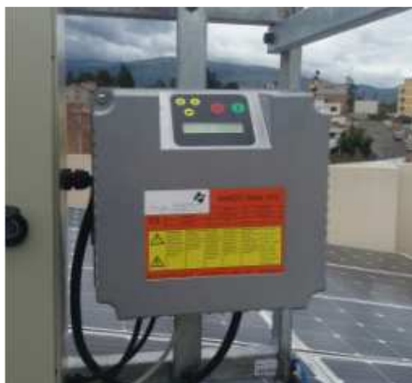
Figura 18-2: Empotramiento del inversor
