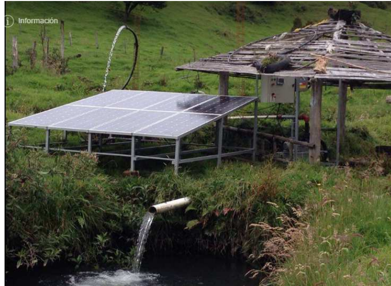
Anexo B: Vista frontal de la estructura de soporte para los paneles
