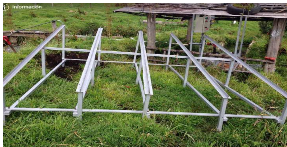
Figura 16-2: Estructura de soporte Realizado por: Alex Lema & Fabián Padilla, 2017
