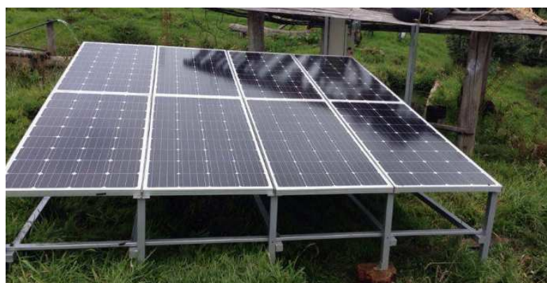
Figura 17-2: Montaje de los paneles Realizado por: Alex Lema & Fabián Padilla, 2017
