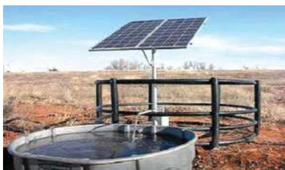
Figura 2-1: Sistema de Bombeo por energía solar
