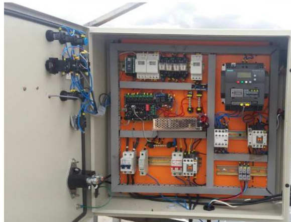
Figura 26-2: Cableado de los elementos de control y potencia Realizado por: Alex Lema & Fabián Padilla, 2017
