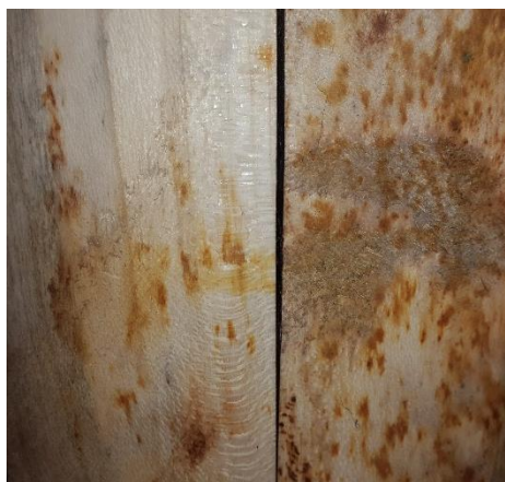
Figura. 11. Presencia de oxidación en MC2.
