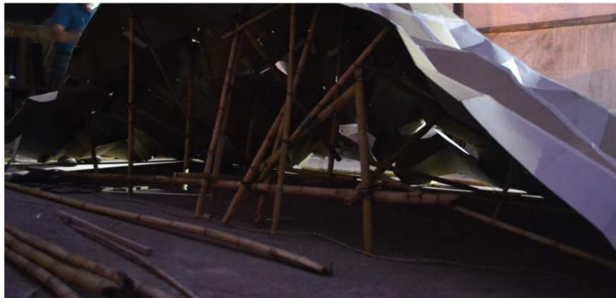
Construcción de estructura para la montaña
