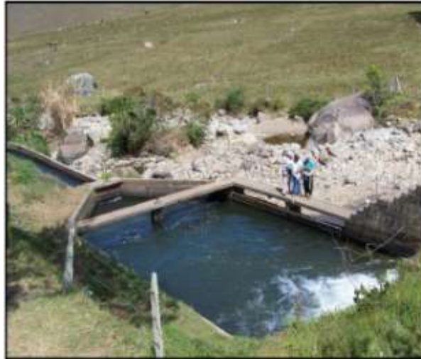
Figura 12-3 Desarenador convencional
