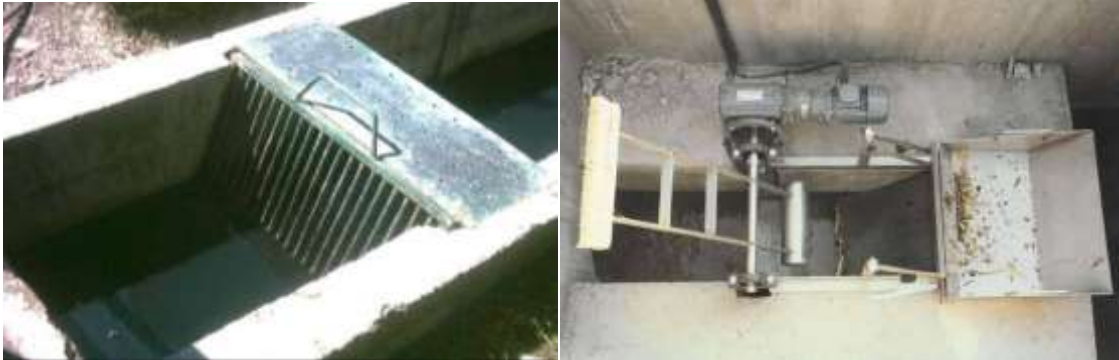
Figura 10-3 Rejillas de limpieza manual y mecánica
