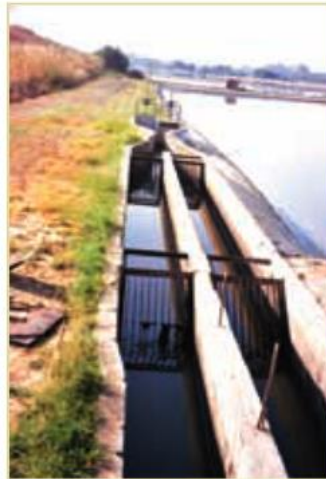
Figura 2-1. Pretratamiento con rejillas
