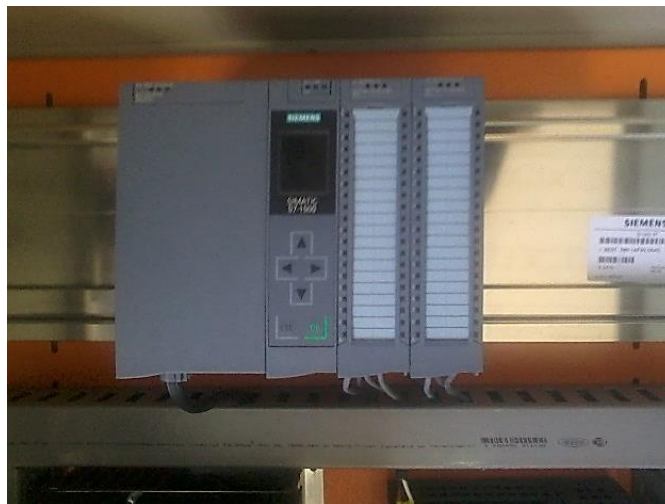
Figura 75. Montaje de PLC 1500
