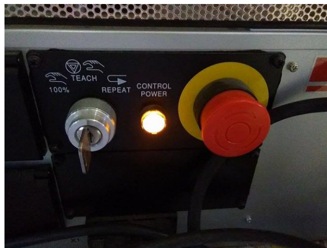
Figura 102. Controlador modo manual
