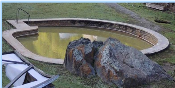
Fotografía N°5: Piscina del Balneario (M3 y M5)
