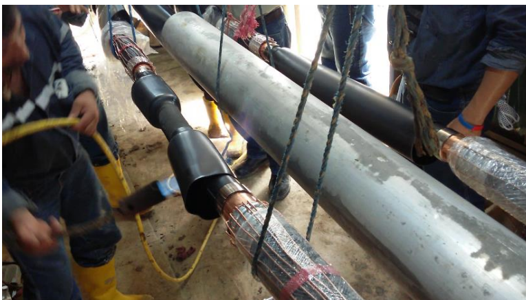
Figura; 9-2 Empalmes termocontráctiles
