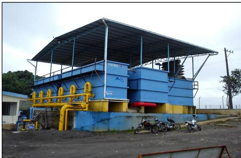
*Figura N° 18-3: Sistema de Planta modular compacta de tratamiento de agua*
