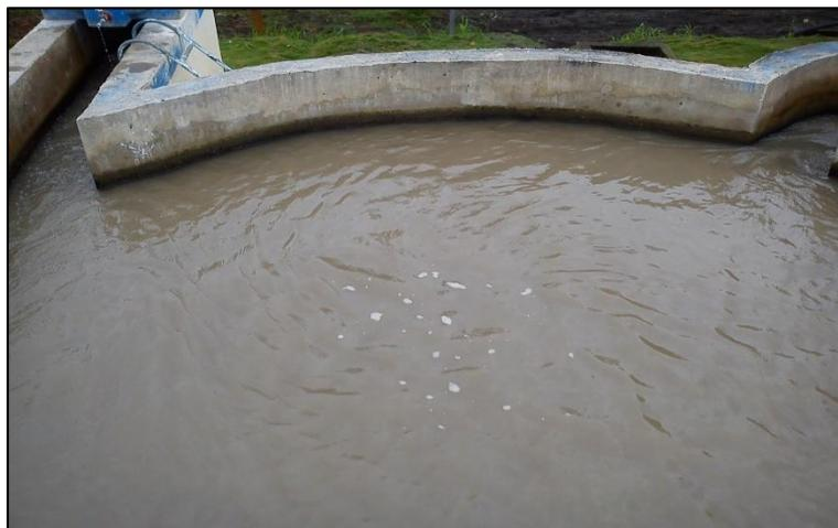
*Figura N° 8-3: Desarenador*
