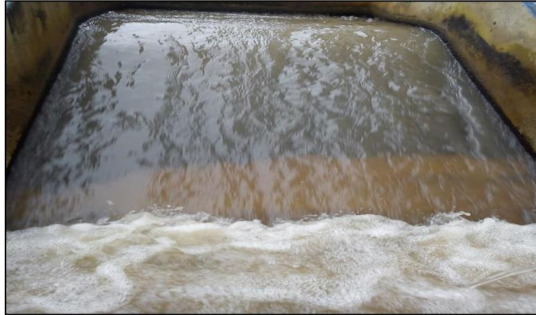
*Figura N° 11-3: Cámara de mezclado rápido*
