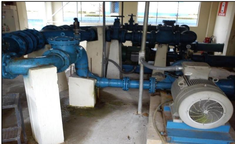
*Figura N° 17-3: Bombas de impulsión*
