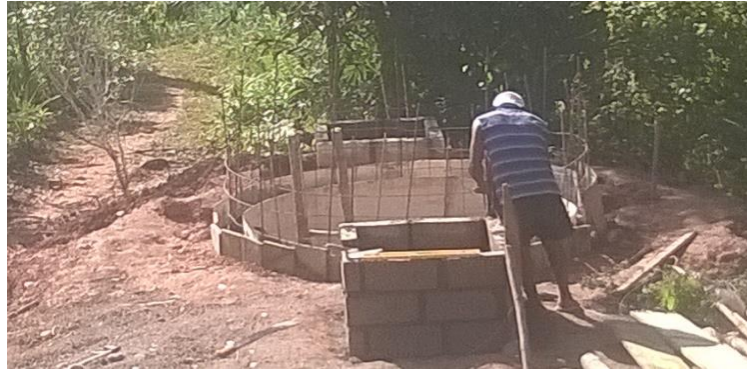
Fotografía 10 – 2: Construcción de la caja de entrada de estiércol
