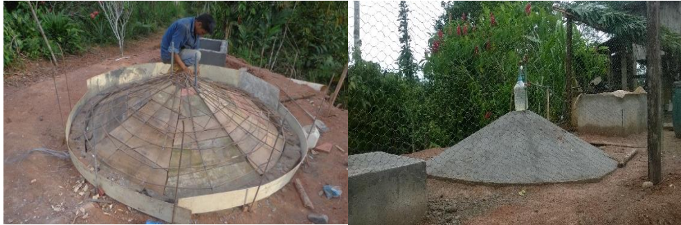
Fotografía 13 – 2: Construcción de la cúpula del biodigestor
