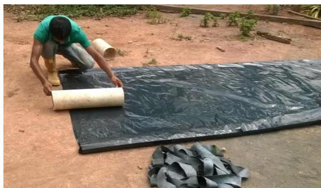
Fotografía 18 – 2: Elaboración del gasómetro
