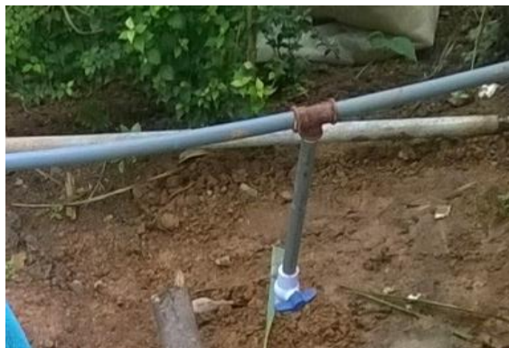
Fotografía 15 – 2: Construcción de la trampa de agua
