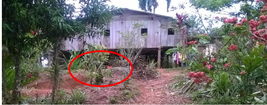
Fotografía 3 – 2: Selección del área donde se construyó el biodigestor
