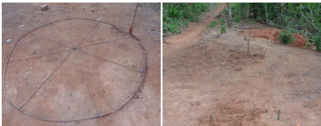
Fotografía 5 – 2: Marcación del lugar donde se realizó la excavación.
