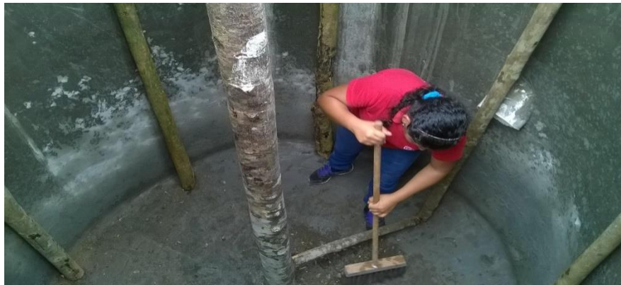
Fotografía 20 – 2: Limpieza en el biodigestor
