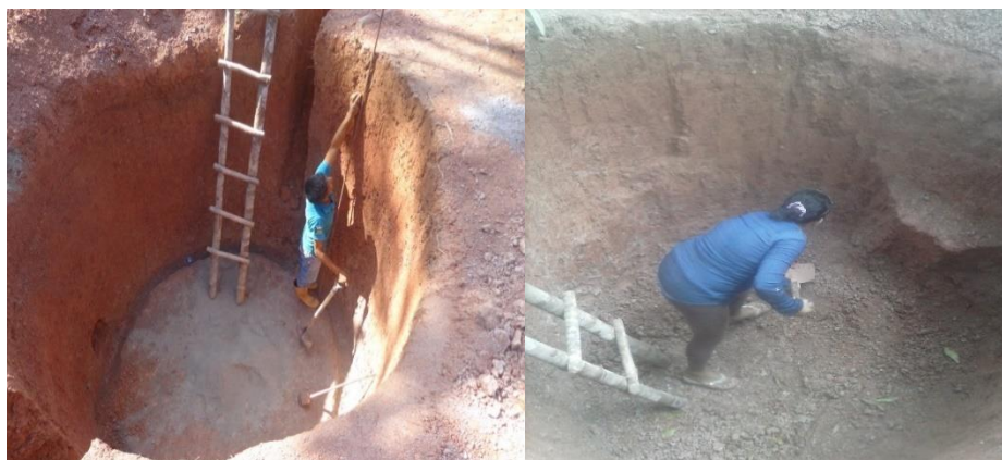
Fotografía 6 – 2: Excavación del agujero, zanjas de entrada y salida.
