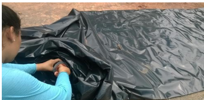
Fotografía 17 – 2: Construcción del gasómetro
