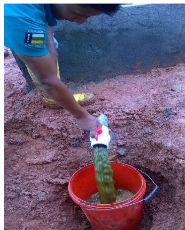
Fotografía 11 – 2: Construcción de la caja de salida de biol.
