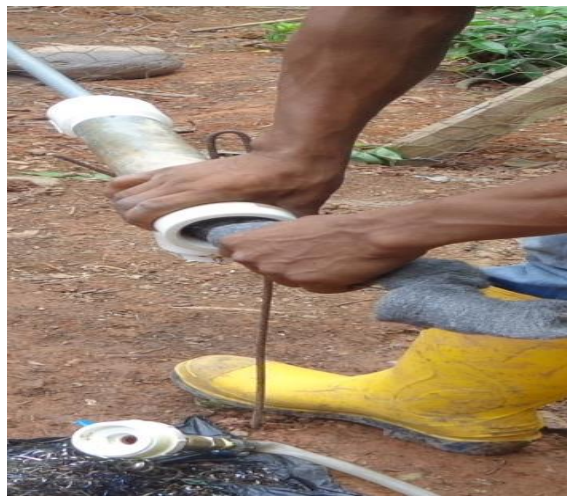
Fotografía 16-2: Construcción del filtro para ácido sulfhídrico
