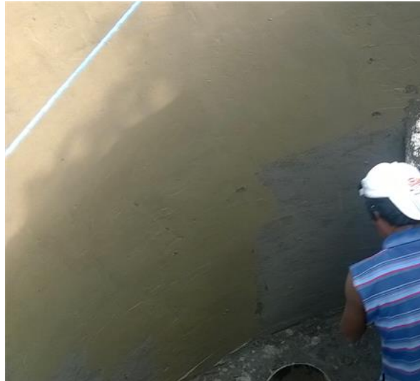
Fotografía 9 – 2: Enlucido de la cámara del biodigestor
