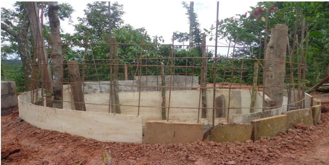
Fotografía 8 – 2: Construcción de la cámara del biodigestor
