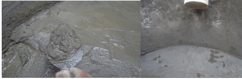
Fotografía 7 – 2: Construcción de la base del biodigestor
