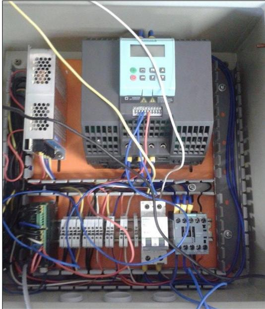
**Figura 19-2 Cableado de los dispositivos electrónicos**
