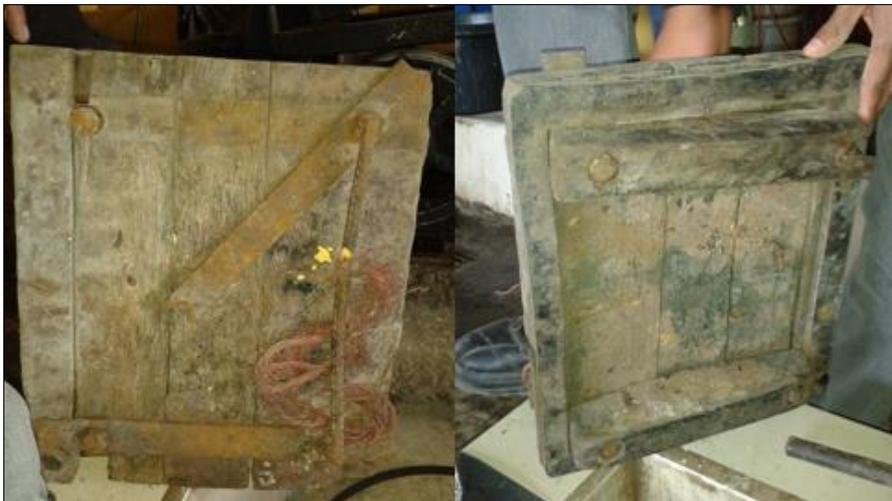
**Figura 5-2 Estado actual de la tapa antes del mantenimiento**
