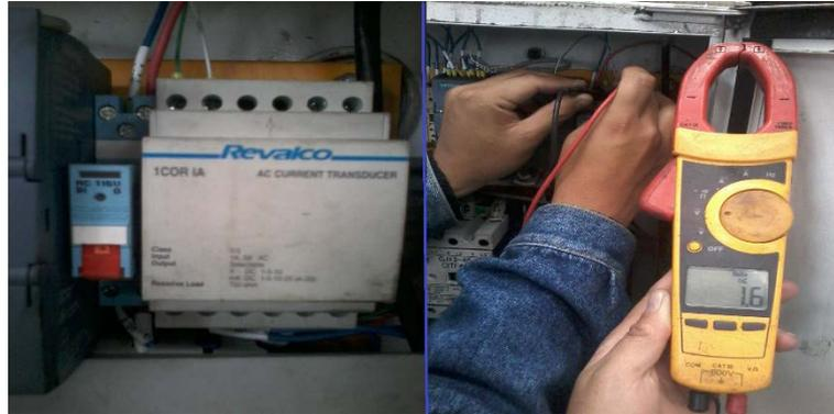
**Figura 2-4:** Medición señal de salida del transductor
