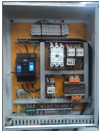
**Figura 3-3:** Tablero Eléctrico del Torno DMTG (Antes)
