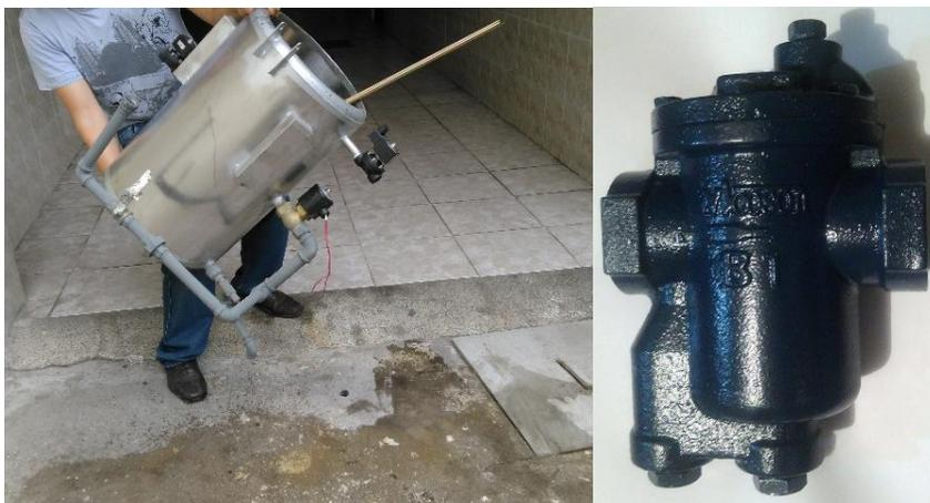
**Figura 2-2** Vaciado del condensado, trampa de vapor
