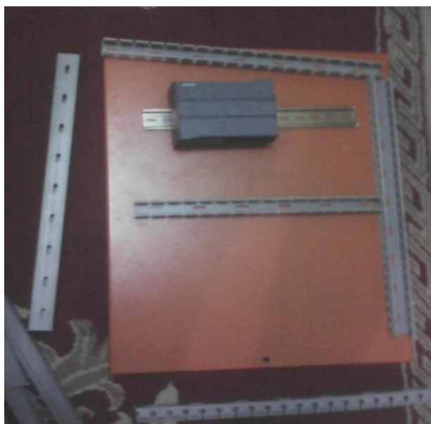
Figura 17-2. Instalación de rieles y canaletas
