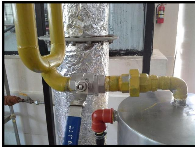
**Figura 6-3:** Válvula de reflujo
