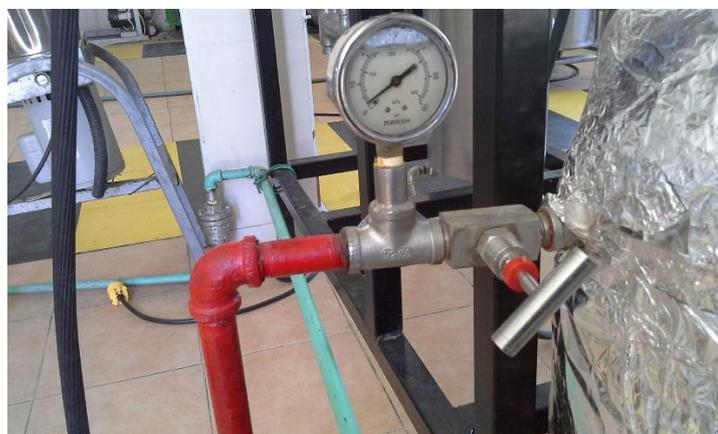
**Figura 3-3:** Válvula manual para regulación de temperatura
