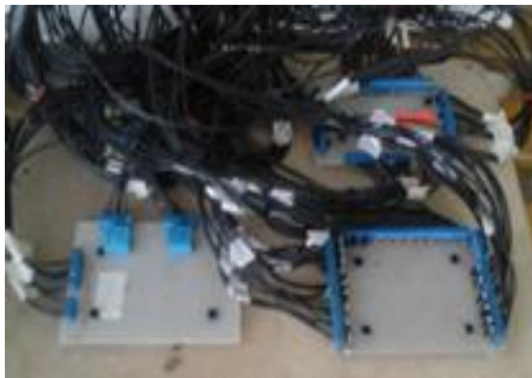
Figura 54.Montaje de los elementos en el módulo
