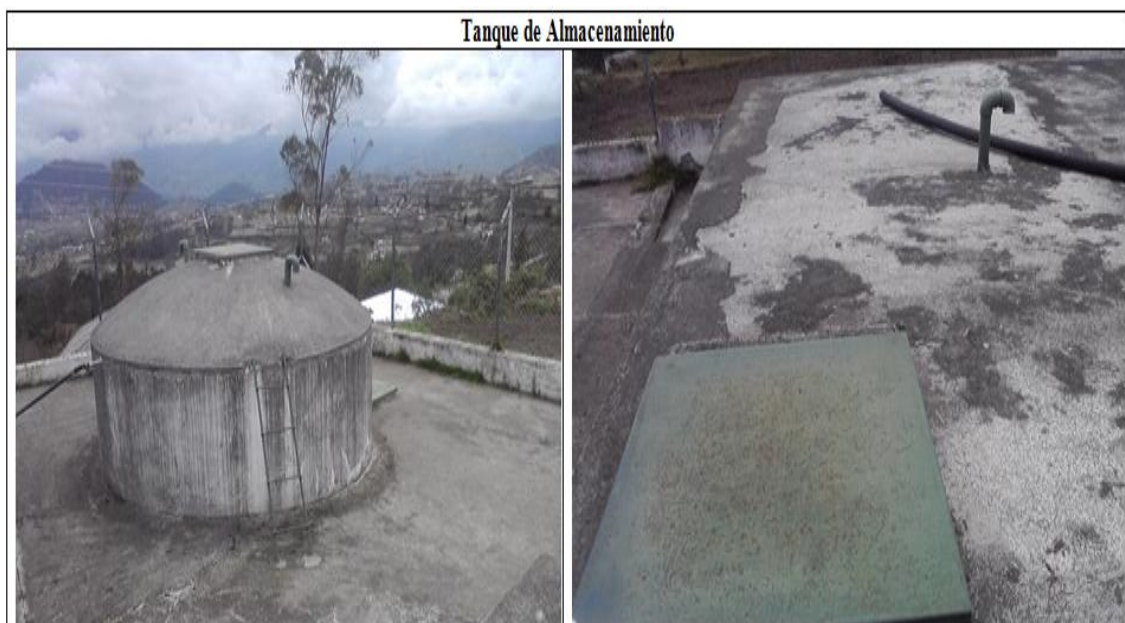
Figura 3-2: Lugar de muestreo, tanque de Almacenamiento.
