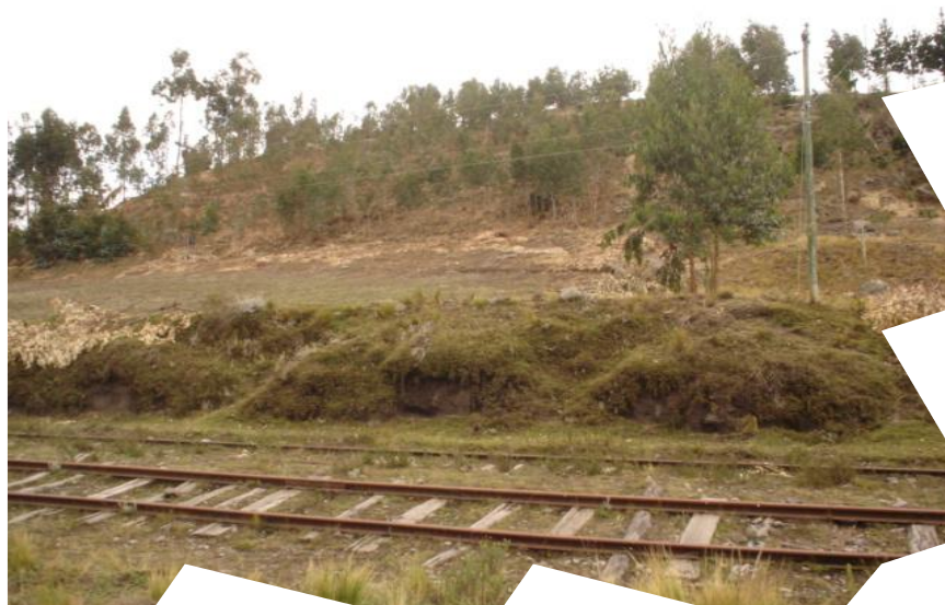
Fotografía N° 21: Área para la construcción
