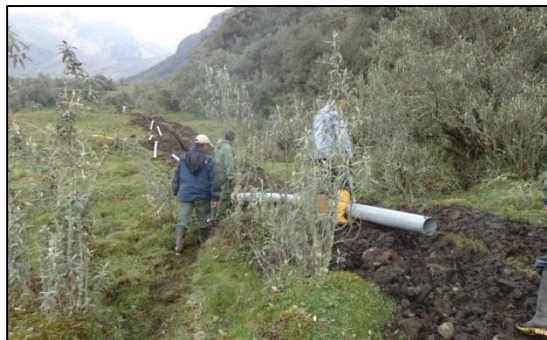
Figura17. Colocación de tubos PVC
