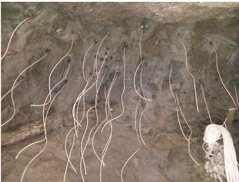
Fotografía 3-2: Carguío de barrenos. Elaborado por: Ríos Wilmar. (2016)
