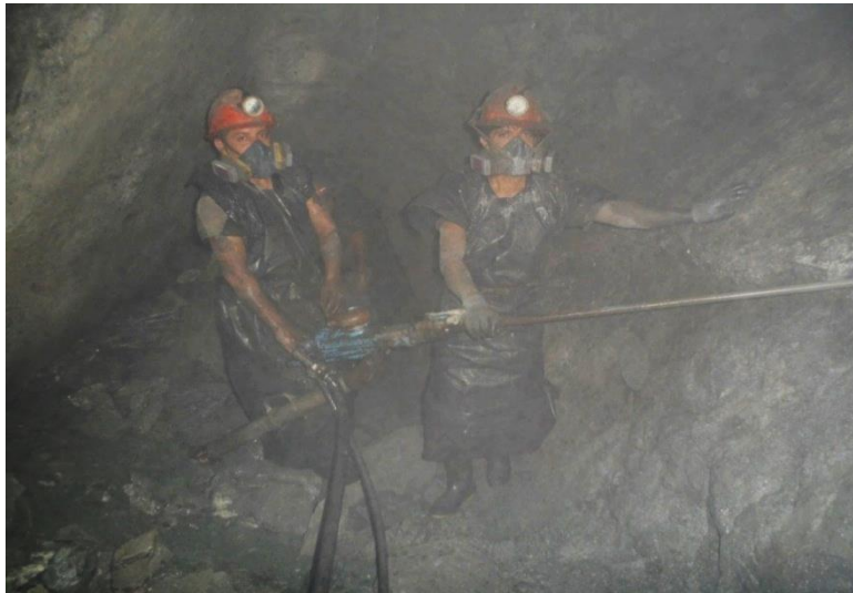
Fotografía 2-2: Perforación en veta. Elaborado por: Ríos Wilmar.
