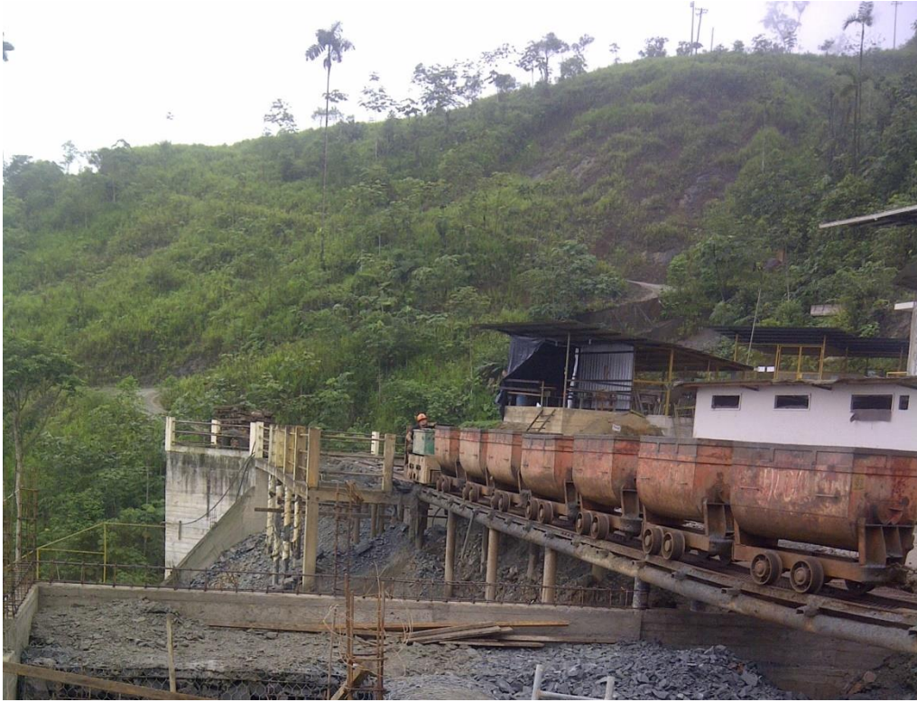
Escombrera, transporte del material estéril.
